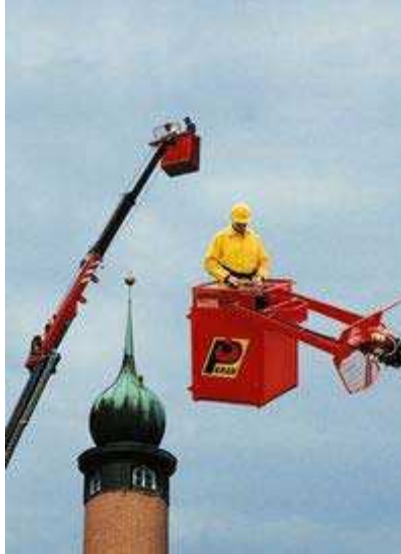
Arbeitsplattform, angebracht an Lastkränen
